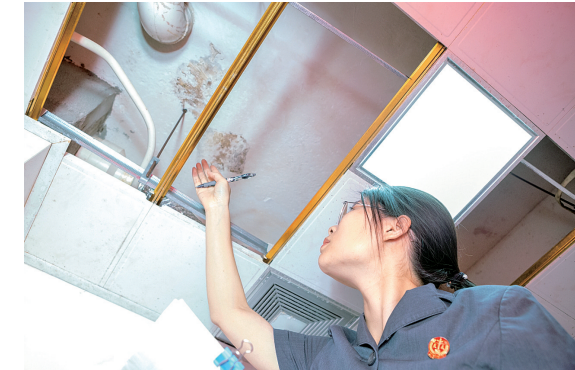
图为广东省广州市海珠区人民法院法官马婷婷到现场查看漏水情况。 陈建忠 摄
