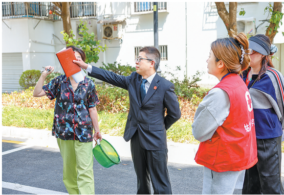
图为江苏省苏州市吴中区人民法院行政庭庭长周宏（左二）来到绣浪苑实地查看楼栋具体情况。陶萌颖 摄
